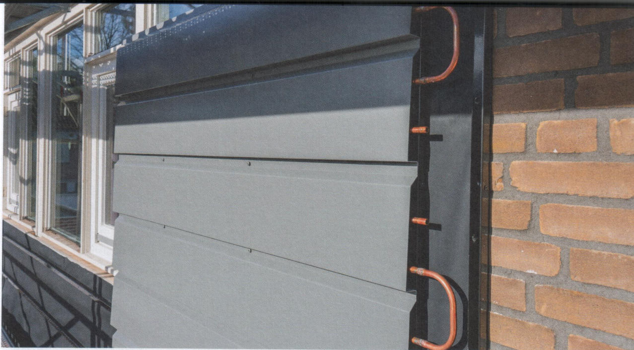
De warmtewin-gevel wordt voor de bestaande gevel gemonteerd en zorgt voor warmte en in de toekomst ook voor koeling in de woning. (Foto: Emergo)
